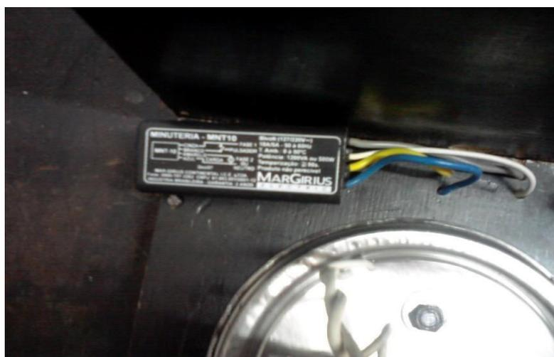
Figura 13: Temporizador para controle do tempo de funcionamento da lâmpada.
