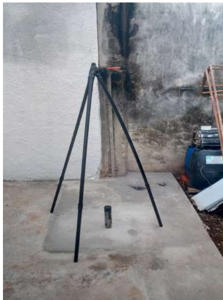
Figura 15: Finalização e acabamento das pinturas e montagem do tripé
