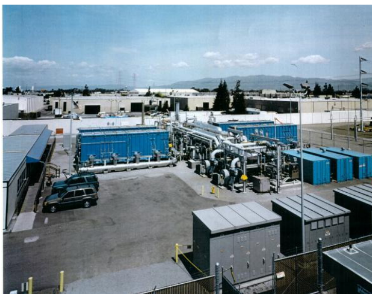
Foto de uma unidade de geração estacionária com células a combustível de carbonato fundido de 2 MW em Santa Clara – Califórnia – EUA.
