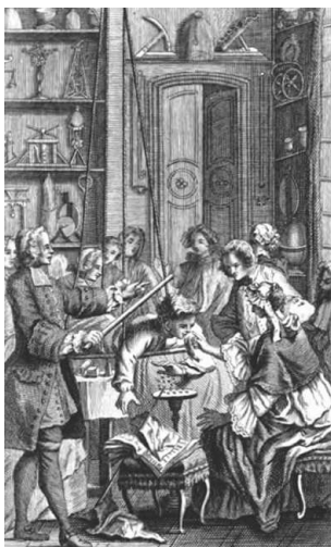
Рис. В.18: Иллюстрация знаменитого опыта Грея в книге Нолле, в [Nol53]. На этом рисунке видно, что стеклянная трубка не обязательно должна касаться мальчика.
