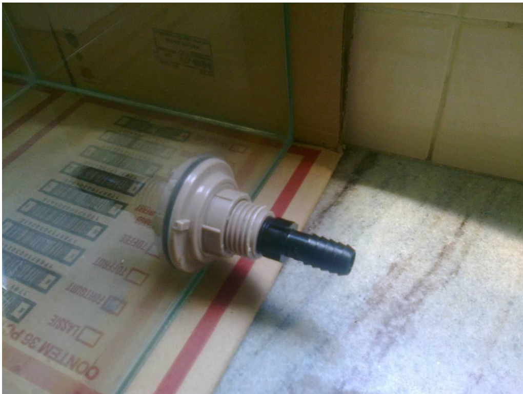
Figura 10 – Flange lateral com adaptador de mangueira de meia polegada (tanque principal).
