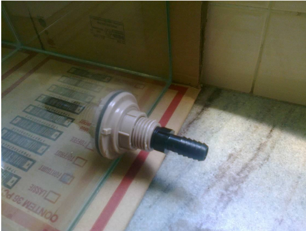
Figura 6 – Flange lateral com adaptador de mangueira de meia polegada (tanque principal).
