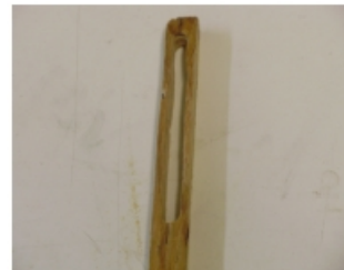
Figura 7. Acabamento nas junção dos furos
