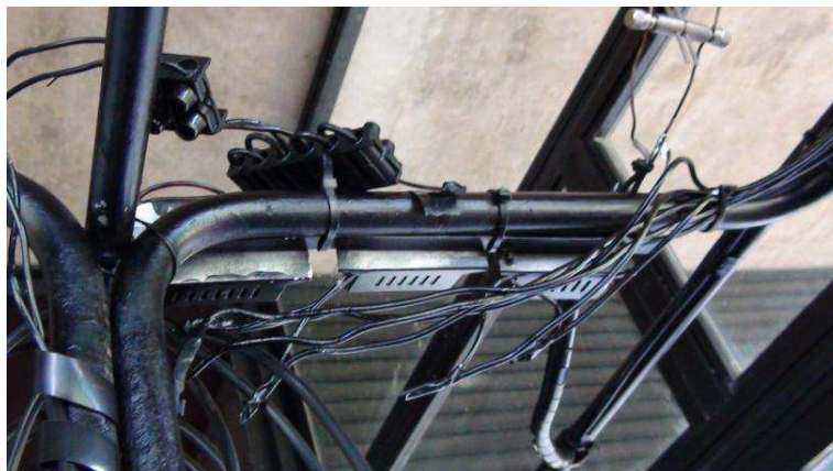
Figura 1 – Montagem dos conversores de tensão para as lâmpadas
