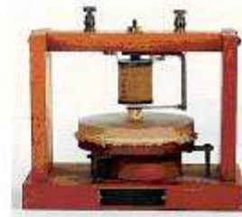
Reprodução do telefone em forma de força, de Graham Bell, utilizado em 1876.
